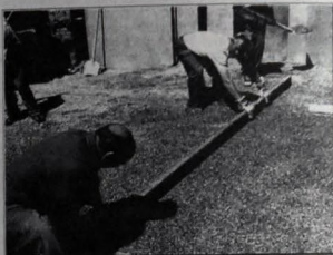
Práce pri ukladaní dlažby na kostolnom nádvori
